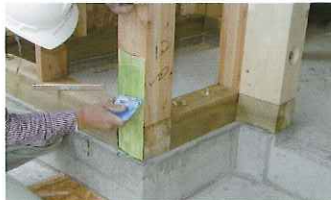
⑤ヘラでしごき、シートに下塗り接着剤を含浸させる
