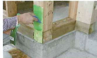
⑦ヘラでしごき、シートに上塗り接着剤を含浸させる
