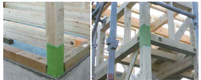
1階柱頭・2階柱脚部 (JB9)
