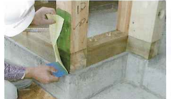
④シート貼り
