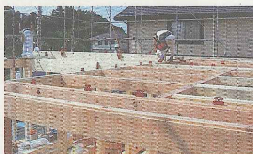
柱頭柱脚もワンスリット。柱の回転が防げるほか、横にずらせば交換も容易にできる
